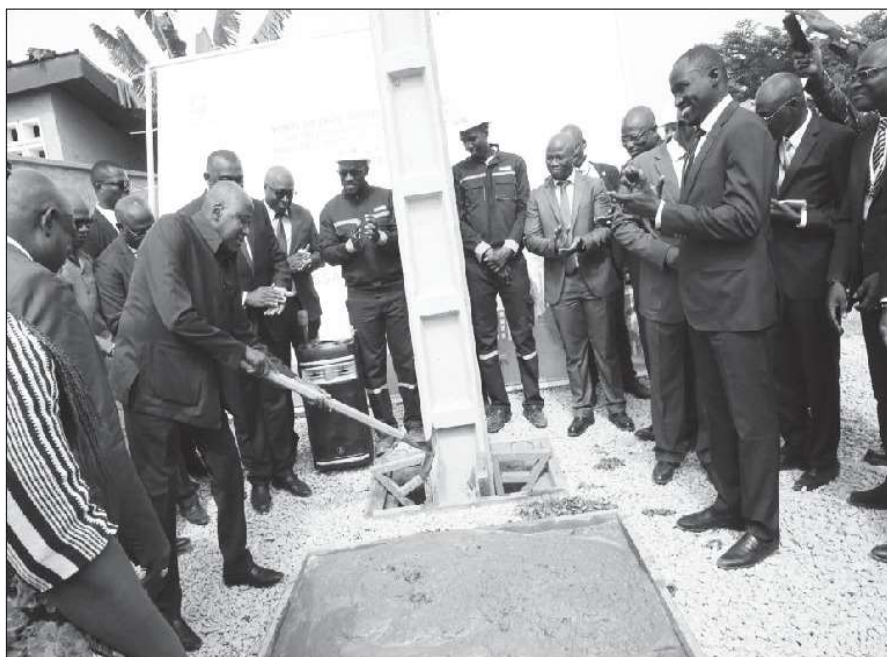
Le Premier ministre a lancé les travaux de l'extension du réseau électrique à Sassandra. (PHOTO : PORO DAGNOGO)
