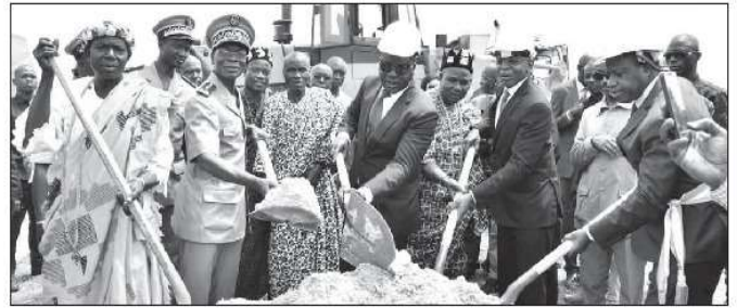
Les ministres Amedé Kouakou et Claude Isaac Dé, entourés des autorités locales, ont donné le premier coup de pelle des travaux. (PH: DR)
