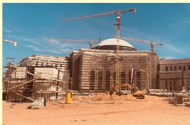
Le futur parlement égyptien en construction dans la nouvelle capitale administrative.
