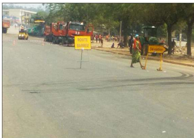
Des travaux en cours au niveau du marché Moh Faitai.
